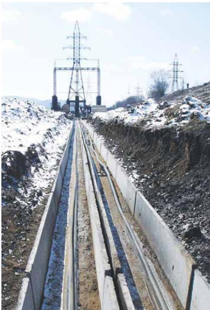
При прокладке кабеля с СПЭ-изоляцией напряжением 110-220 кВ радиус изгиба не должен быть менее  $15xD$ , где  $D$  — наружный диаметр кабеля. При использовании специального шаблона и предварительном нагреве кабеля минимальный радиус изгиба кабеля также должен быть не менее  $15xD$ .
